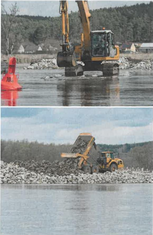
Abb. 10: Bühnenbau bei Siekierki, Fluss-km 653, Foto: P. Schroeder, 31.03.2023
