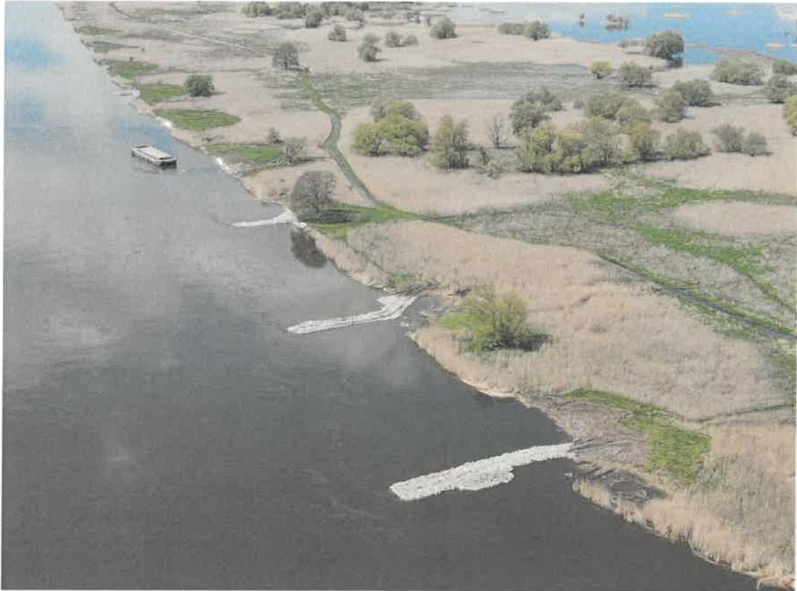
Abb. 5: Noch im Bau befindliche Buhnen bei Altrüdnitz (Stara Rudnica), rechtes Ufer, Fluss-km 659 (Foto: M. Voigt, 03.05.2023)
